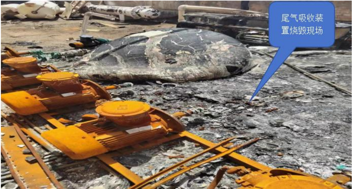
尾气系统烧毁现场
