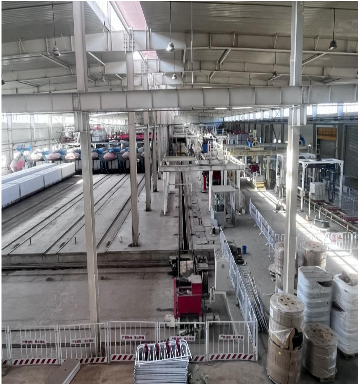
粉煤灰生产场所
