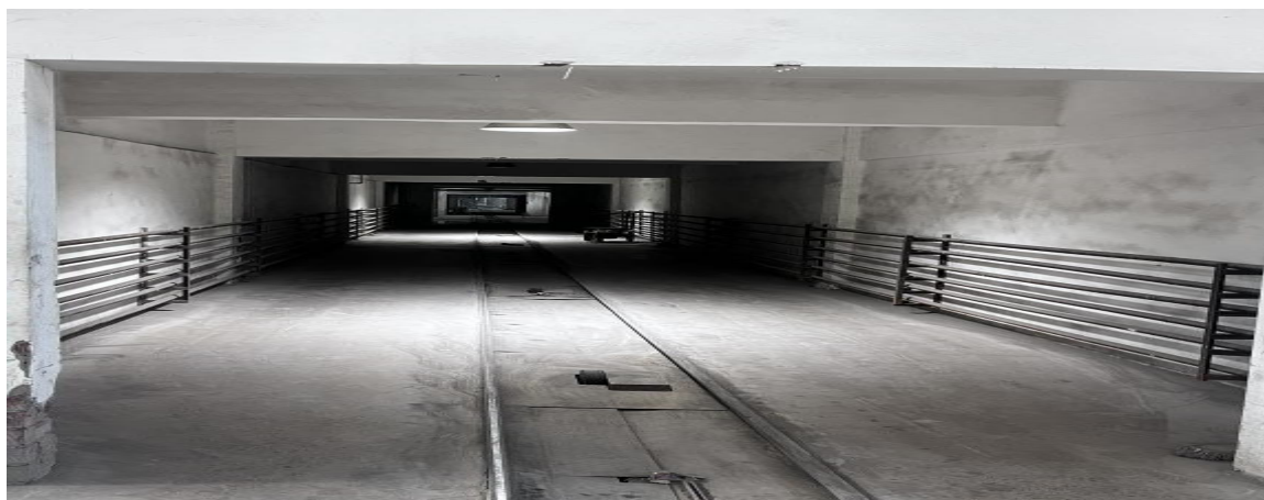
储备成型原料运至静止场所
