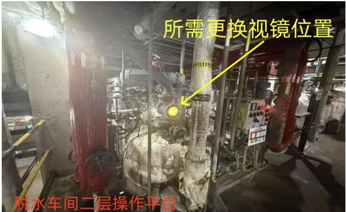
脱水车间二层视镜更换位置
