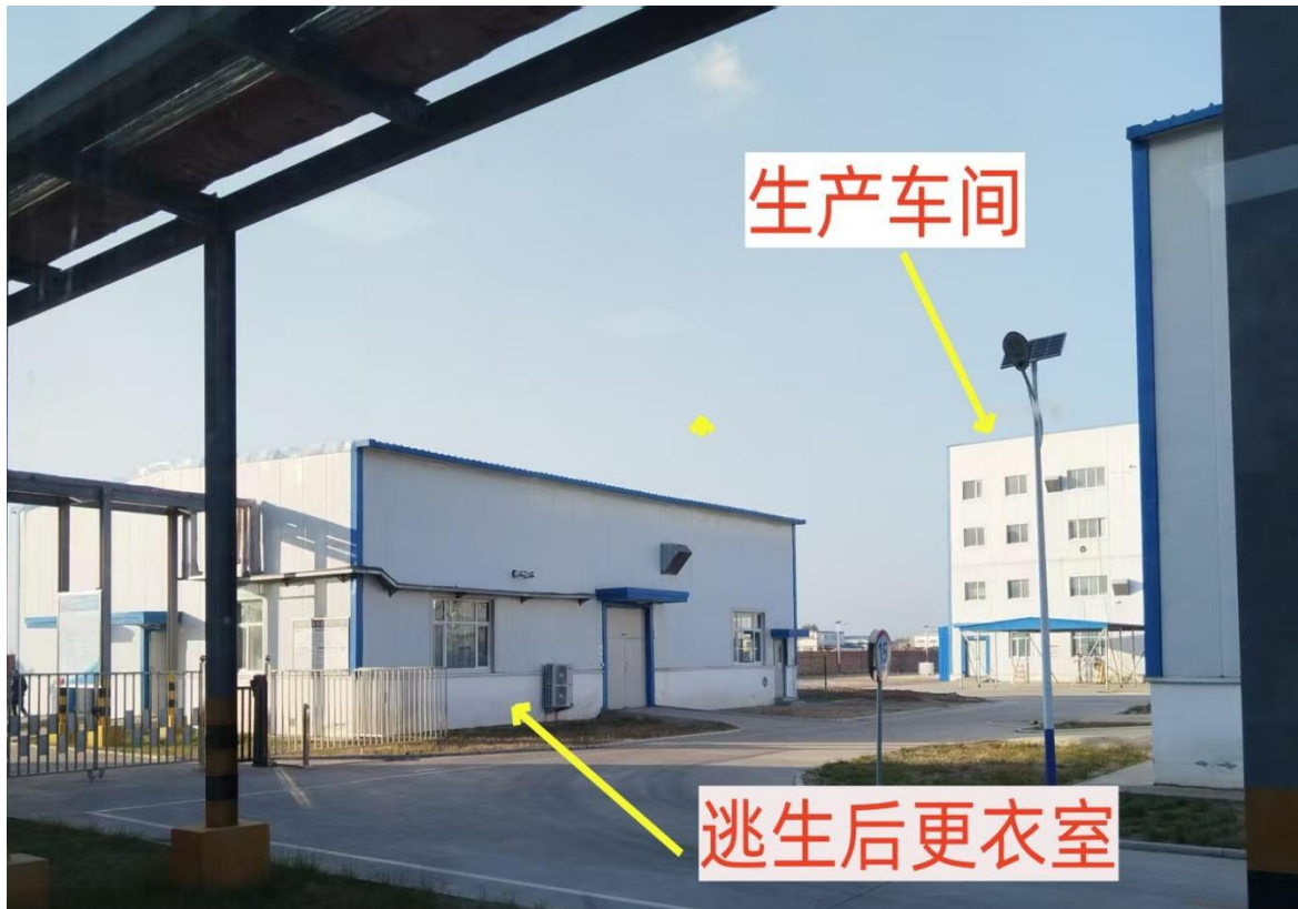
事故现场车间及更衣车间位置
